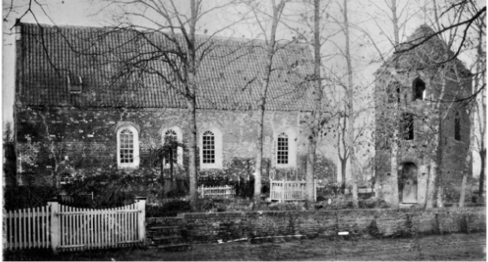
Alte Hollener Kirche mit Glockenturm, Blick von der Hollener Landstraße
